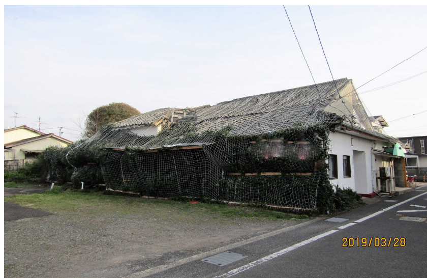
【略式代執行により特定空家等に行った建築資材の飛散防止措置(網の設置)】
