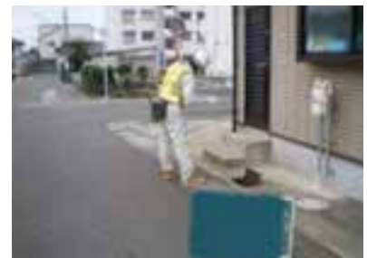
漏水調査状況
