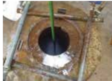
井戸改修状況
