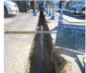
管路更新状況
