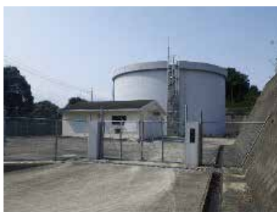
徳泉川内配水池
