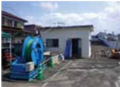
井戸改修全景
