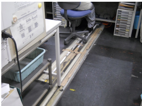
図 2-12 床への配線（本館）
