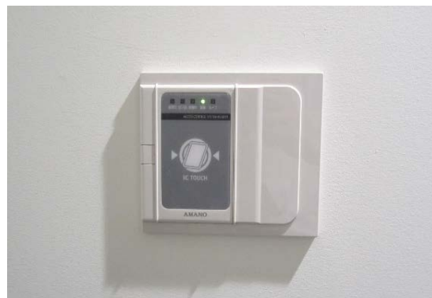
図 6-14 ICカードによる入退室管理の例
