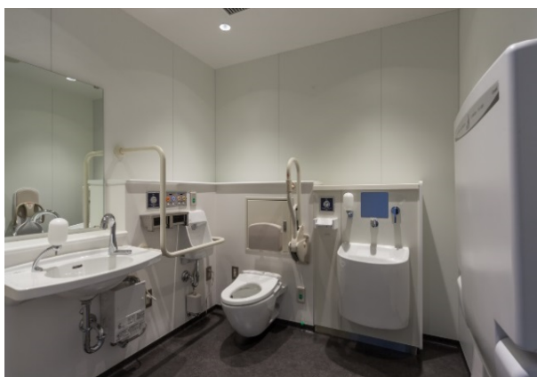
図 6-10 多目的トイレの例
