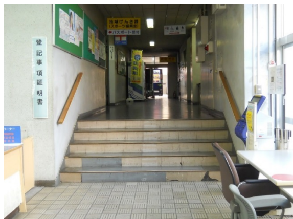
図 2-6 本館と別館との通路の階段（本館）
