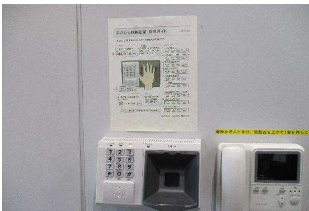
図 6-15 手のひら認証による入退室管理の例
