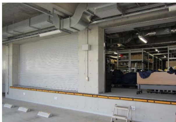
図 20 備蓄倉庫の例
