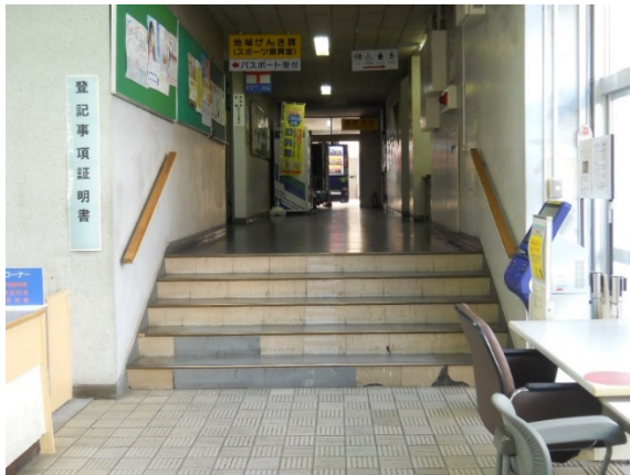
本館と別館の通路の階段（本館）
