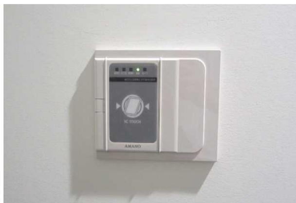
図 6-14 ICカードによる入退室管理の例
