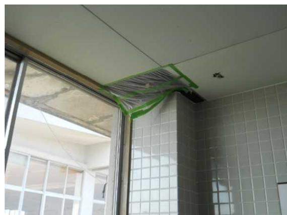
図 2-5 雨漏り（上下水道局）
