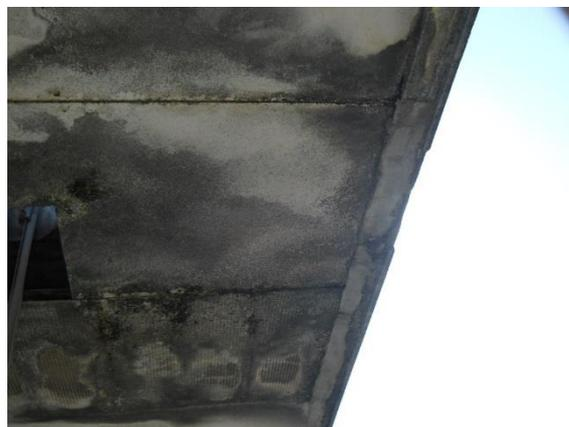
庇先端のモルタル剥離（上下水道局）
