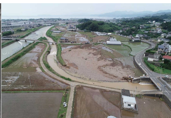
【令和2年7月豪雨災害 福重地区】
