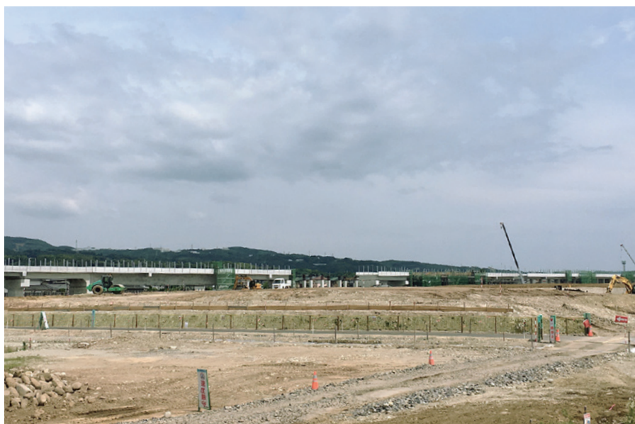
工事が進む新幹線車両基地
