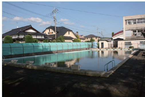
写真2-30 西大村小学校のプール
