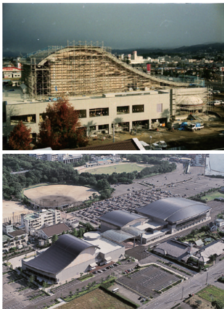
写真2-4 体育文化センターの工事、完成
