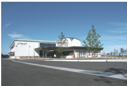
写真2-6 建設当初のアルカディア大村 (株式会社アルカディア大村提供)
