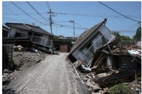
写真2-23 新耐震基準による建築家屋も被災（熊本地震）
