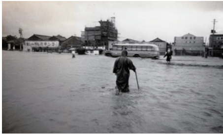
写真2-24 大村駅前から見た水害状況
