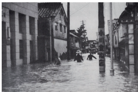
写真1-34 諫早豪雨時の被害状況
