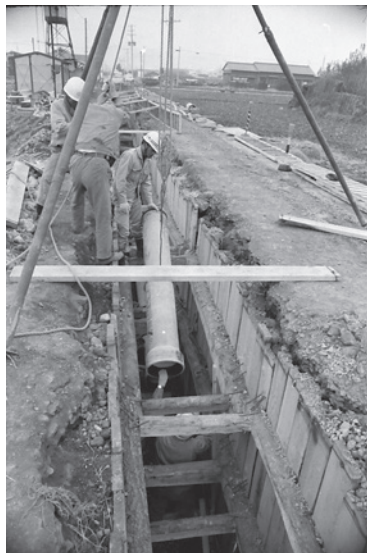
写真1-46 下水道工事風景
