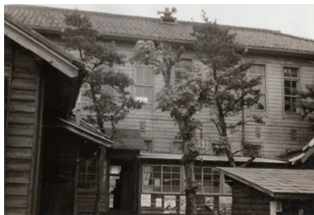
写真1-36 市役所本館（一階庶務課付近）
