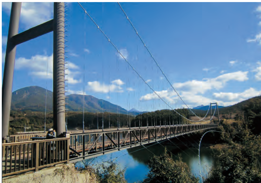
写真3-24 平成13年12月完成した橋長125mの野岳大橋
