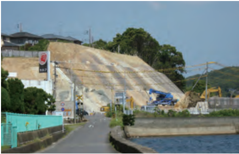
写真1-3 与崎国道拡幅工事に伴って出現した毛屋層下部層の露頭。砂岩泥岩の互層で一部に石炭層を挟む、地層は60°で手前側に傾斜している。一瀬(1953)が与崎層を記載した場所であるが現在はコンクリートでふさがれ露頭は見えない (2010年撮影)
