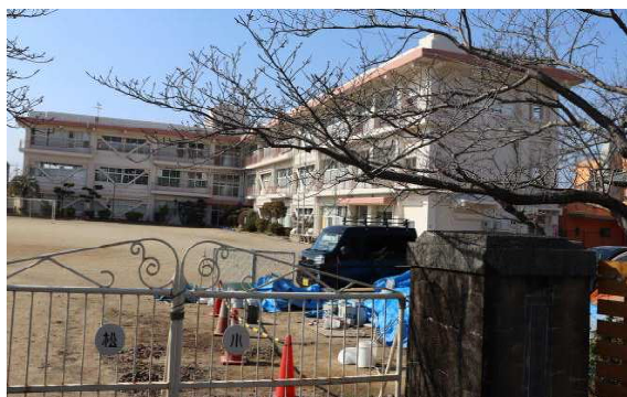
(塗り替え後は淡い色合いの外壁です)
