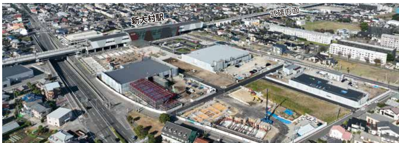
開発が進む新大村駅さくら口(東口)
