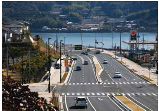
国道34号久原2丁目交差点付近
