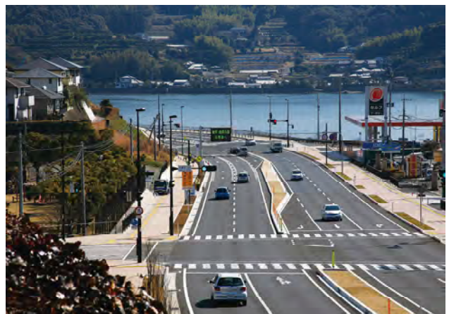
国道34号与崎交差点付近
