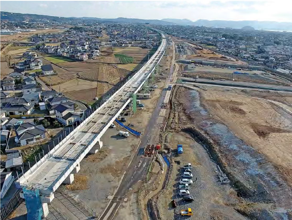
九州新幹線西九州ルート竹松高架橋工事のようす
