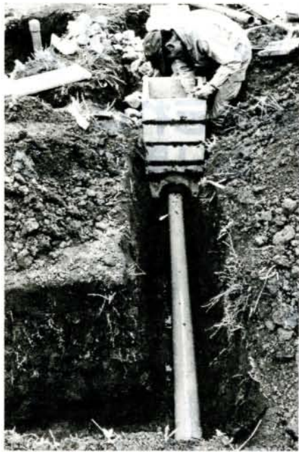
雑排水処理施設の設置状況
