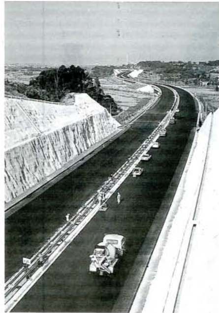
開通を間近にひかえ、最後の仕上げにかかる九州横断自動車道（坂口付近）
