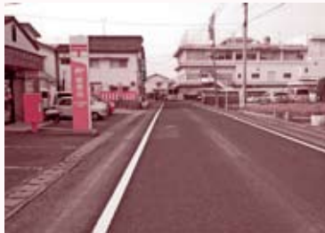
(施工事例)路側帯の拡幅とセンターラインの抹消
