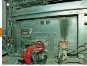
焼却炉に投入したごみを勢よく燃やします。焼却炉内の温度は約900度。高い温度で燃やすことで、ごみのおいをなくします。
