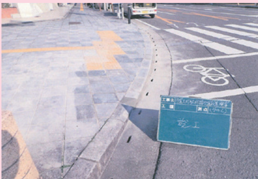
◀歩道段差解消事業(市道大村駅前線)
