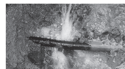
水道管の老朽化による漏水状況
