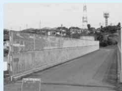
通学道路の整備(落下防止柵)
