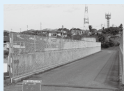
通学道路の整備(落下防止柵)
