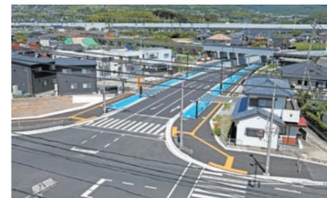
国道34号のバイパス機能を有し、市街地の渋滞緩和と、新幹線新大村駅や高速道路大村インターチェンジへのアクセス向上を図る主要幹線道路で、県内初となる自転車道を備えています。平成27年に小路口工区(池田2丁目～鬼橋町)が完成、令和4年3月に竹松工区(鬼橋町～沖田町)が完成し、全線開通しました。
