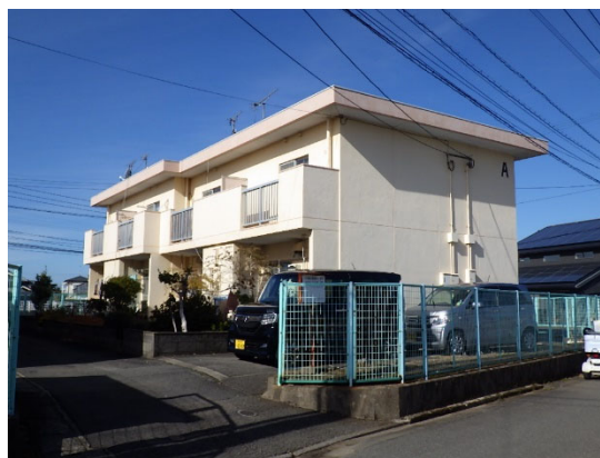
簡易耐火構造二階建て住宅
