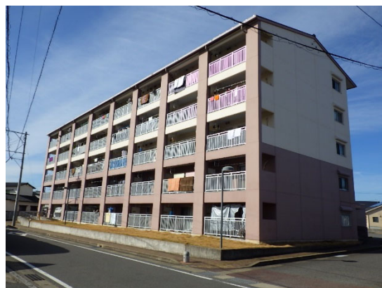
中層耐火構造住宅
