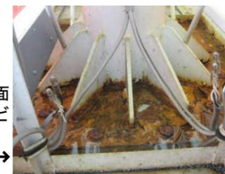
↑柱根元のサビを放置し、倒壊。
