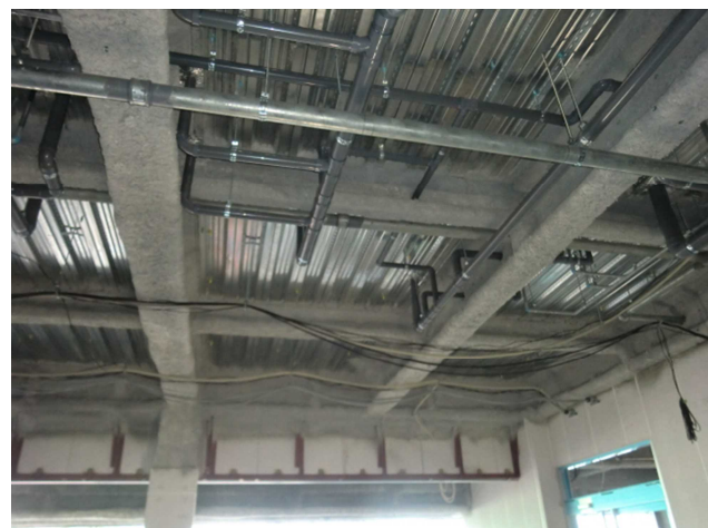
設備配管施工状況
