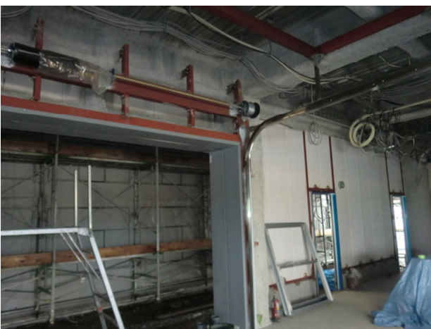
オーバースライダー支持鉄骨
