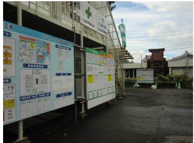
工事関係標識掲示状況
