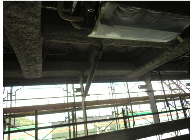
カーテンウォール吊材フレーム
