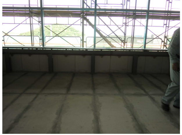
ALC 床パネル敷設状況
