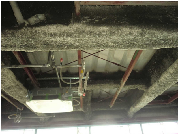
空調機器取付状況
