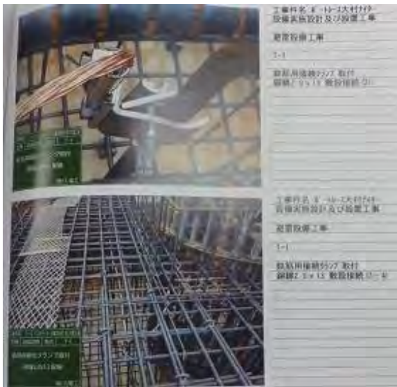
構造体への設置方式 鉄筋用クランプ接続工事写真
