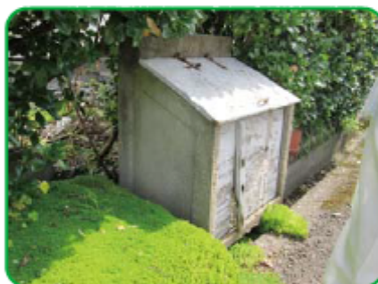
大村市特有のコンクリート製ごみボックス
