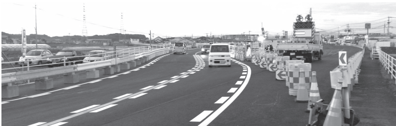
(国道34号高縄手橋 (松原交差点付近) は、現在、本線が工事のため、一時的に迂回路仮橋での通行になっています)
