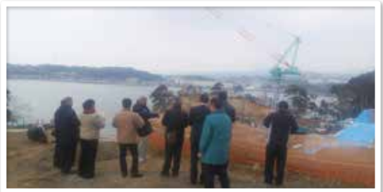
釜川内に建設中の一般廃棄物最終処分場の建設現場を視察する総務委員会
