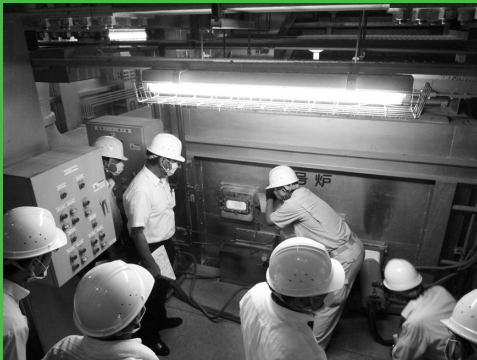
環境センターの焼却炉（1号炉）の現地調査を行う建設環境委員会
