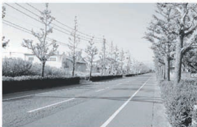
市道杭出津松原線（富の原2丁目付近）
