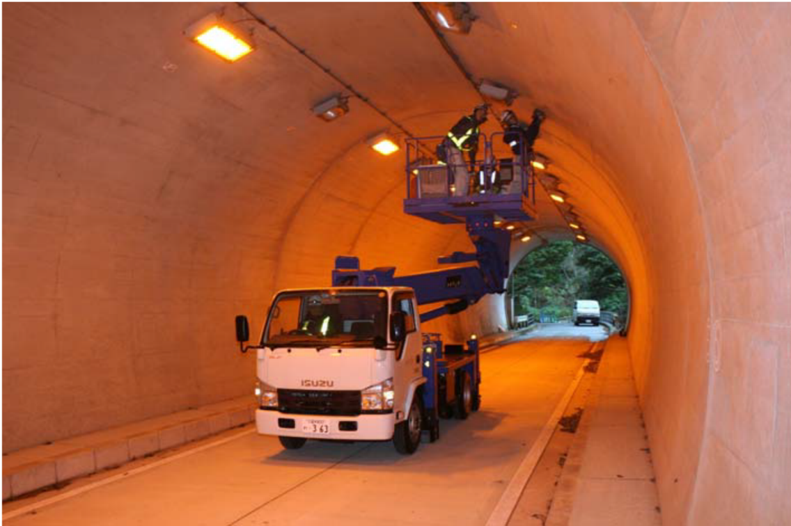
高所作業車による点検
