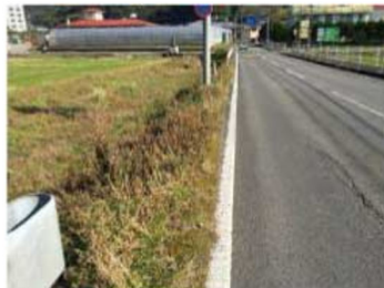
防護柵がない場所の調査及び対策検討
